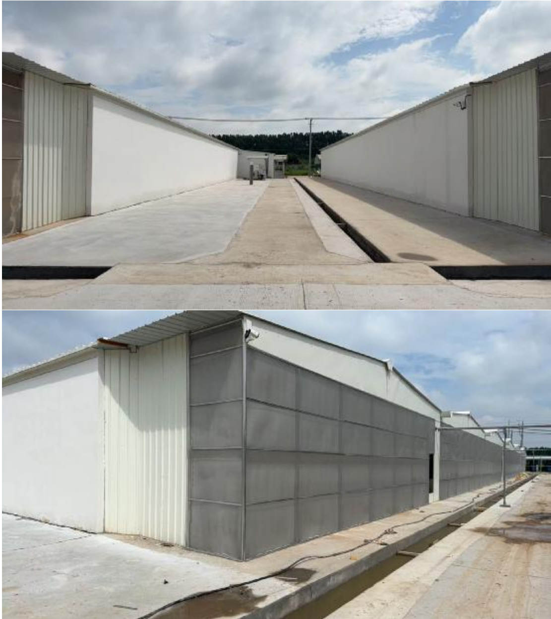
项目现场照片（2026.7）
