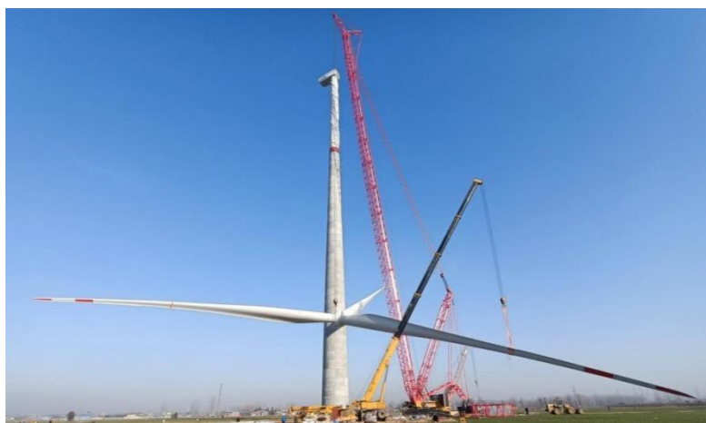
图 2-3 整机吊装
