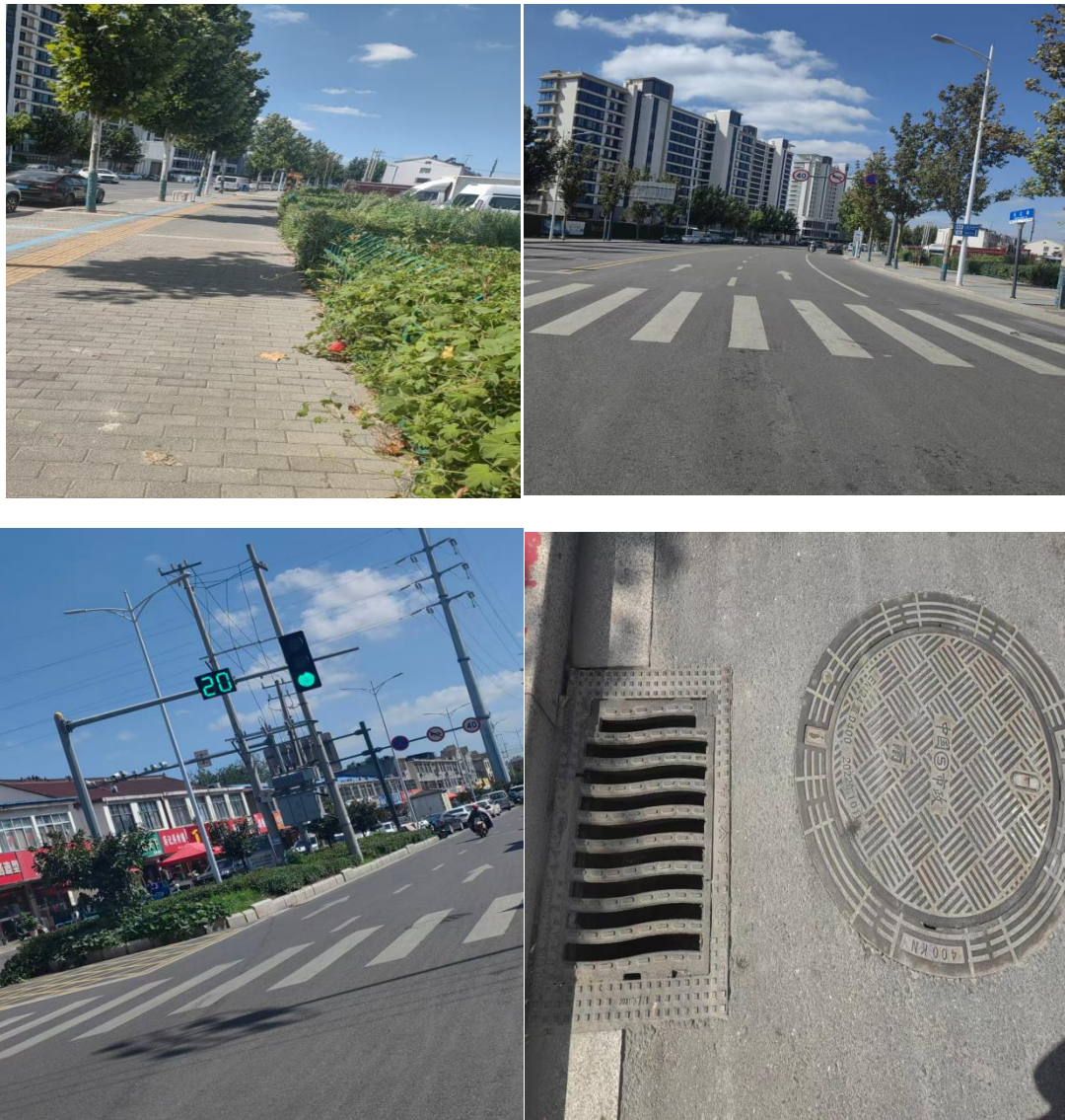
附件 4：项目区照片（拍摄于 2026 年 8 月）
