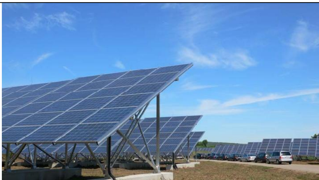
图2-1 固定式安装方式
