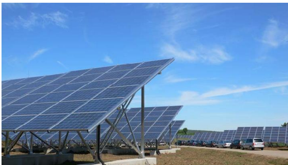
固定式安装方式示例图
