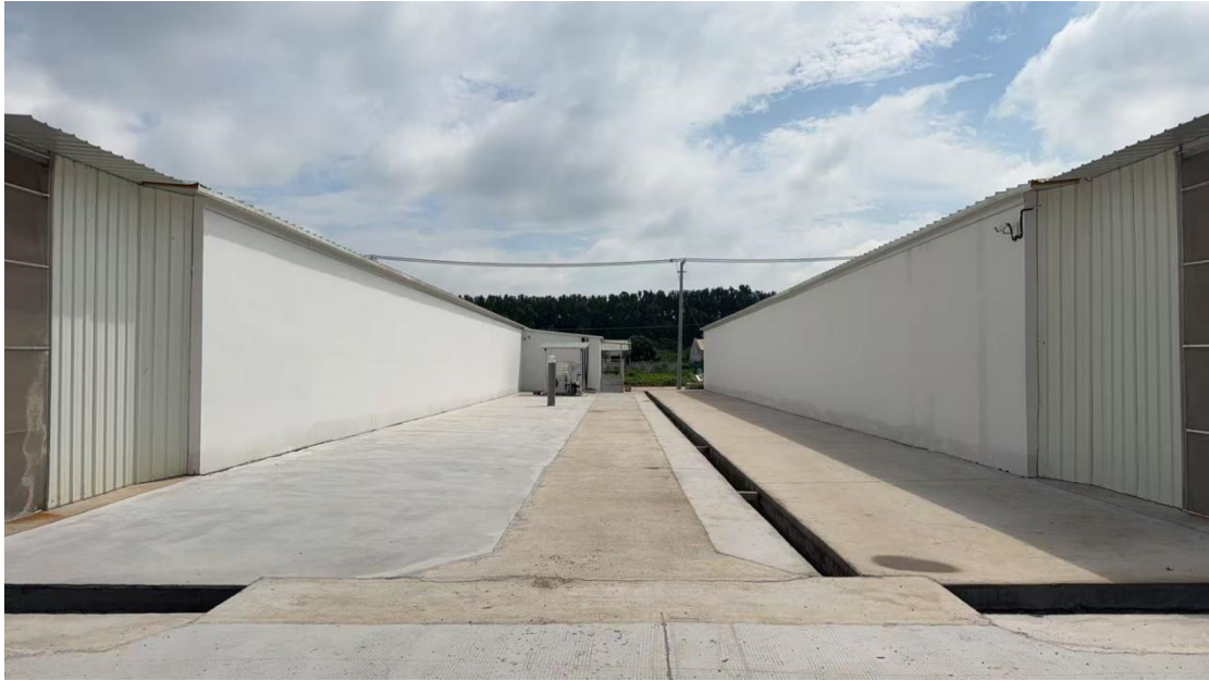
附图3、项目建设现场图
